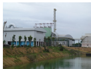
โรงไฟฟ้าพลังงานชีวมวล
